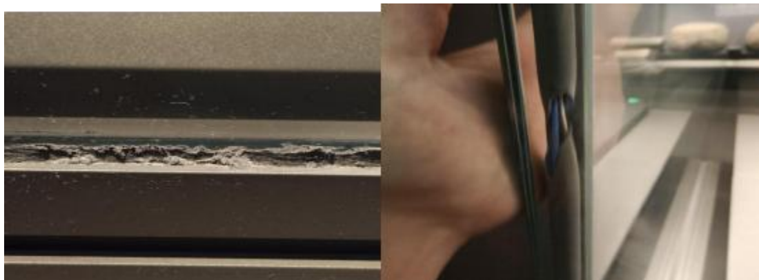
展柜底部密封胶严重老化 影响密封性及美观性
