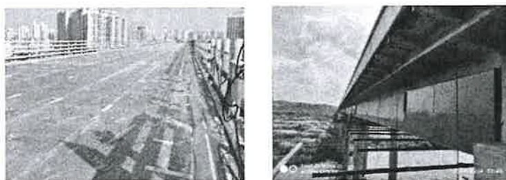
图 2 UHPFRC 在组合桥面板、混凝土梁桥组合加固中的应用
