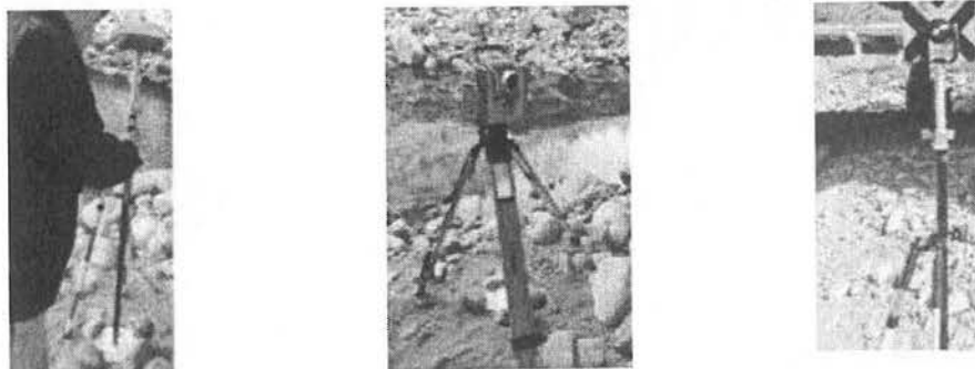
图 2.10 SX10 三维激光扫描仪现场扫描
