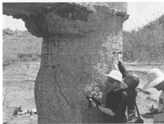
图 2.5 钢筋锈蚀
