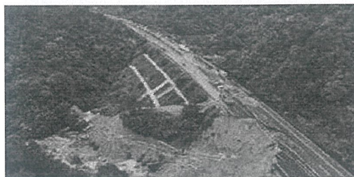
图 1 梅大高速高填方路堤坍塌
