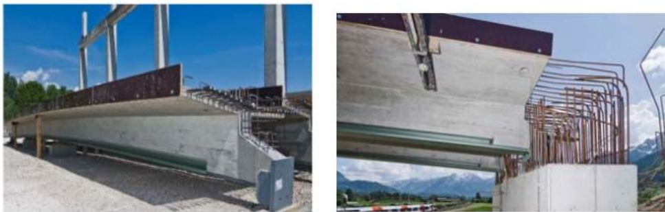
图 1.14 存梁及现场连接
