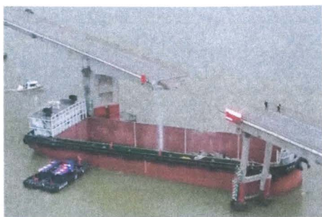
(1) 沥心沙大桥被船舶撞损
