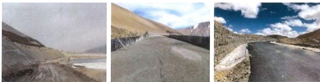
(a) 处治前路况 (b) 泡沫轻质土材料浇筑 (c) 处治后路况(裂缝较多)
