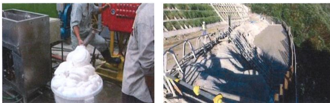
图 2-3 泡沫轻质土用于水毁路基修复工程
