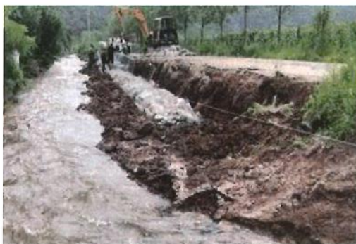
图 2-1 抛填石笼修复冲毁路基
