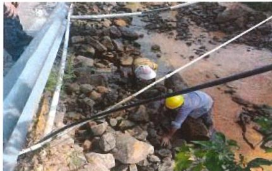
图 2-2 抛石填筑修复滑塌路基
