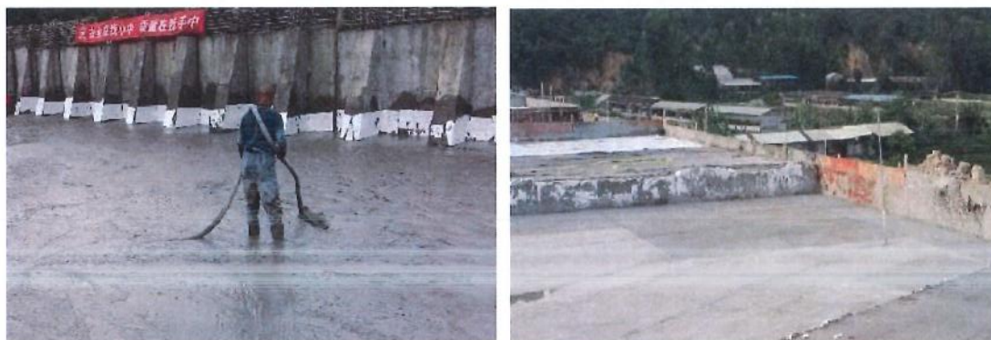
图 2-15 深厚软土地基厚垫层泡沫轻质土路基施工技术
