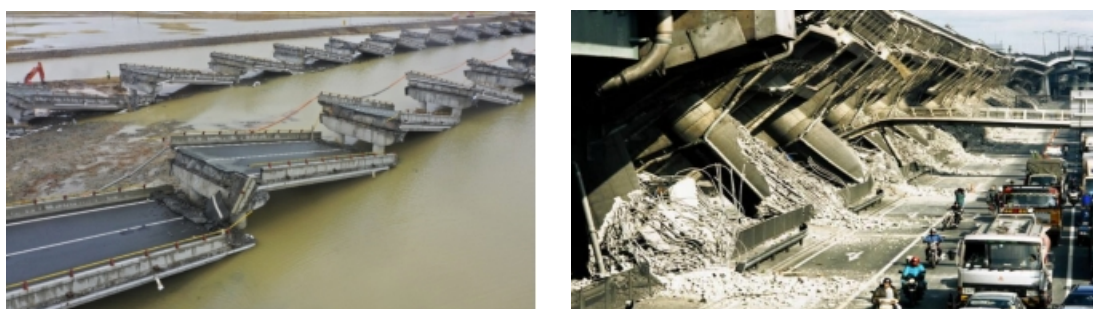
图 2 桥梁在地震下引发的灾害
