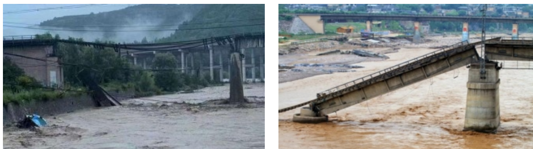
图 1 桥梁在洪水冲击下引发的灾害
