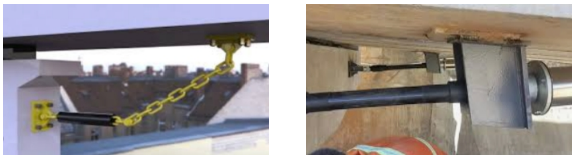
图 4 桥梁中的典型防落梁装置
