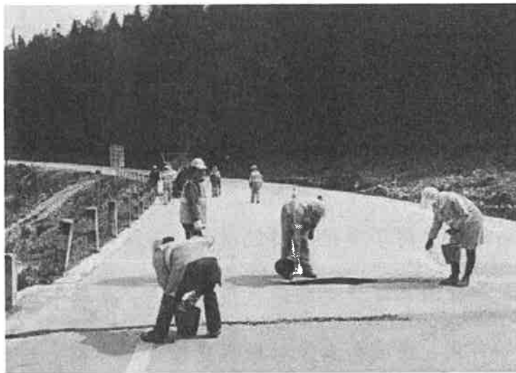
图 1 人工进行公路养护
