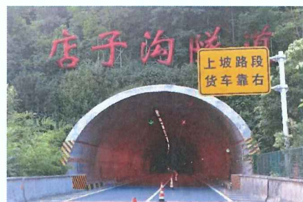
(a) 店子沟隧道石泉端洞门照
