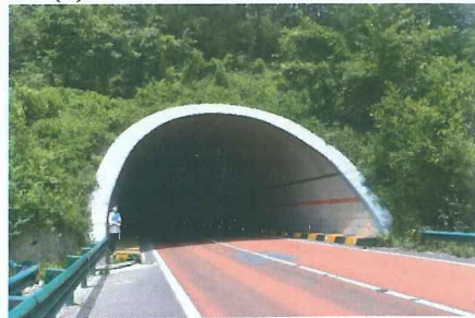
(d) 石泉隧道白河端洞门照
