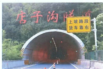
(a) 店子沟隧道石泉端洞门照
