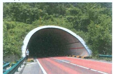
(d) 石泉隧道白河端洞门照
