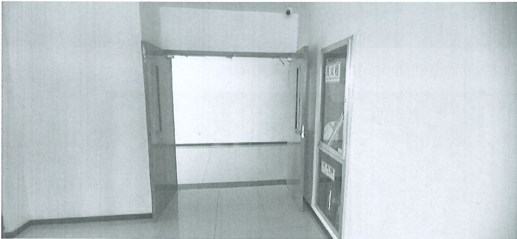
7、楼梯间常开双扇防火门一扇缺少闭门器，整体缺少顺序器，无防火门常闭标识
