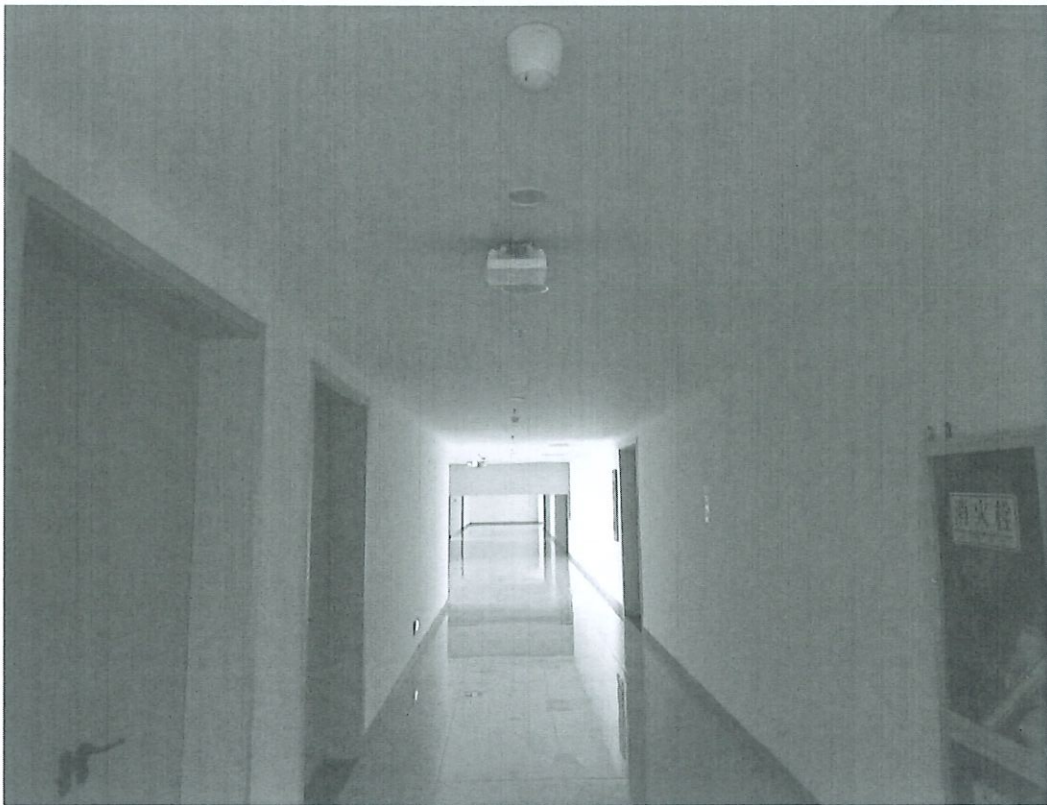
6、五楼联动测试，多数排烟系统未按照所划分的防烟分区正常启动
