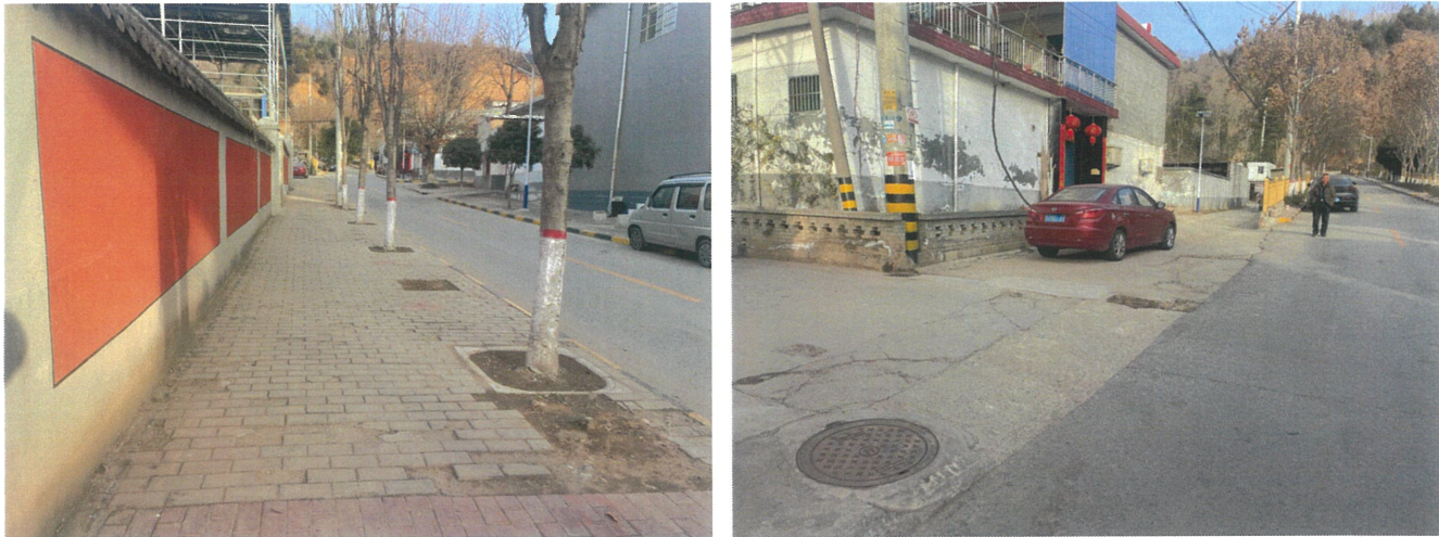
图 5-3 人行道地砖破损、水泥路面破损
