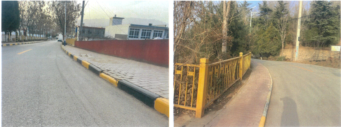
图 5-6 道沿破损，护栏漆面老化
