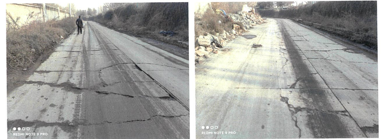
图 3.3-2 K1+421~K1+575 段水泥路面病害
