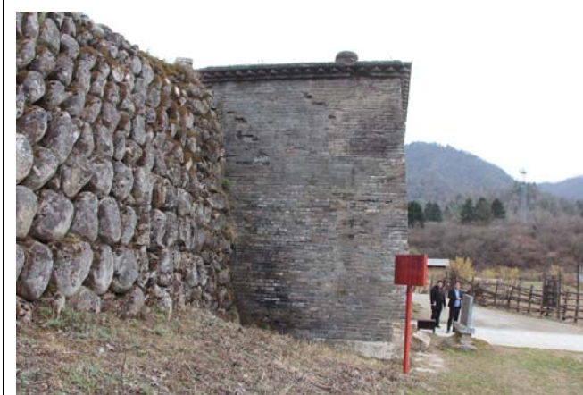
照片 5: 西城门北立面西部, 台顶面渗水, 墙面雨水流出, 灰浆流失。
