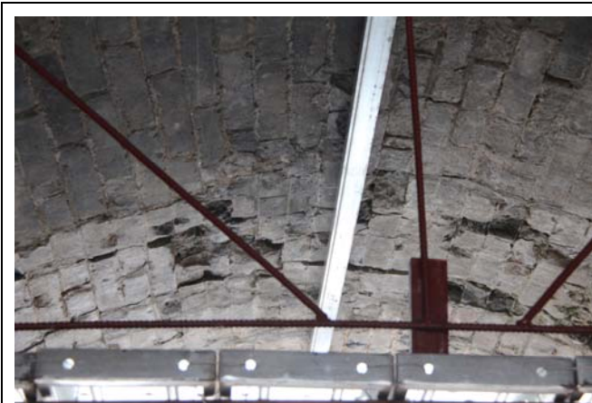
照片 9: 西城门西入口, 券顶多处裂缝, 雨水渗漏, 灰浆流失。
