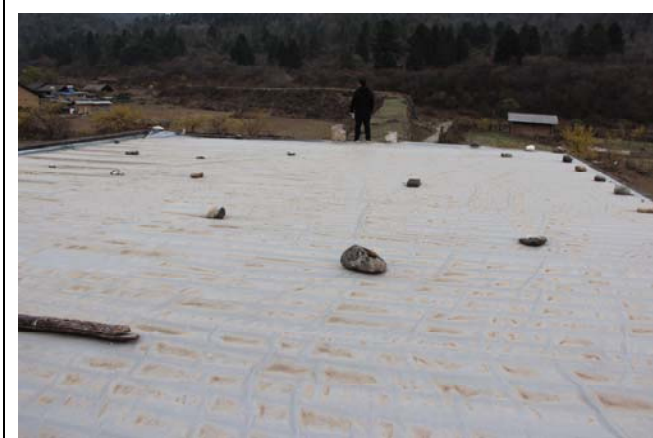
照片 7: 西城门台顶面临时用彩钢板遮盖。
