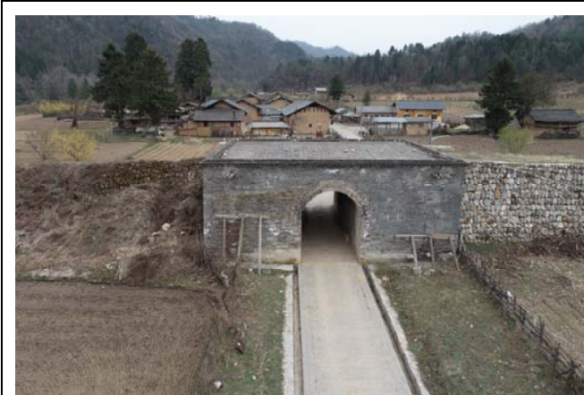
照片 13: 东城门西立面, 墙面鼓胀, 临时支护。
