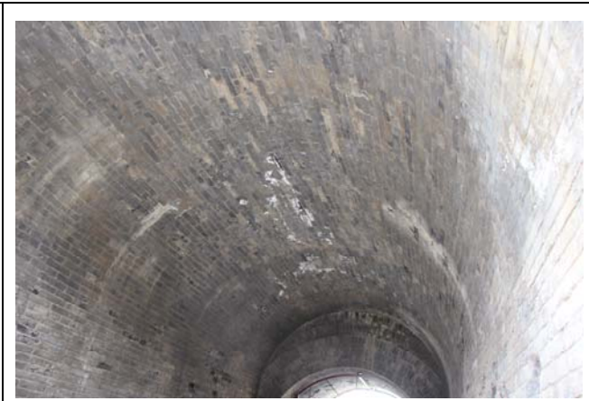
照片 10: 西城门券洞内多处渗水, 灰浆流失。
