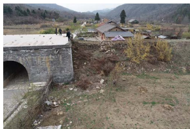
照片 6: 西城门台顶面临时用彩钢板遮盖; 城北墙与城墙相接处现状。
