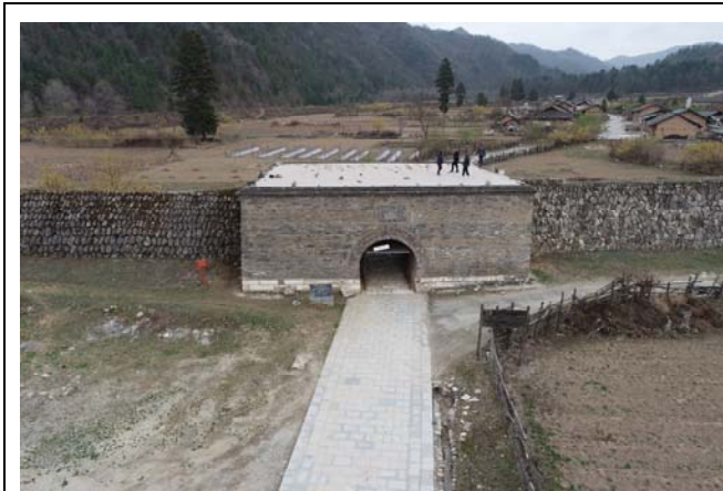
照片 3: 西城门西立面, 顶面临时采用彩钢板遮盖顶面。
