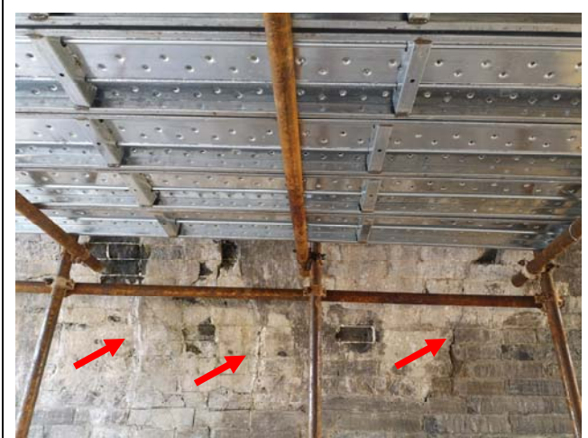
照片 12: 西城门西入口拱券墙体多处裂缝。
