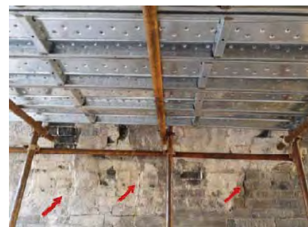
(c) 西门西入口拱券墙体多处裂缝
