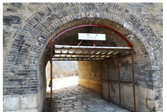
照片 8: 西城门门洞西侧临时支护
