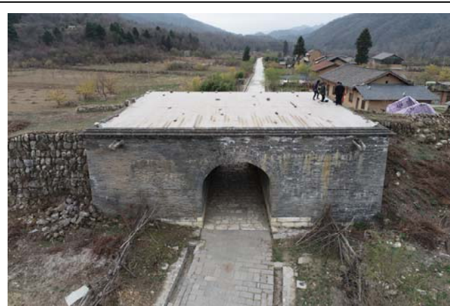
照片 4: 西城门东立面, 台顶面渗水, 东墙面雨水流出, 灰浆流失。
