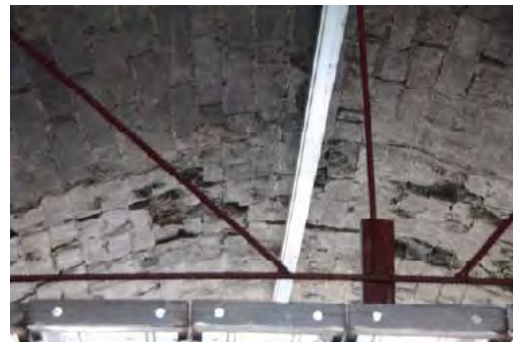
(b) 西门西入口拱券多处裂缝
