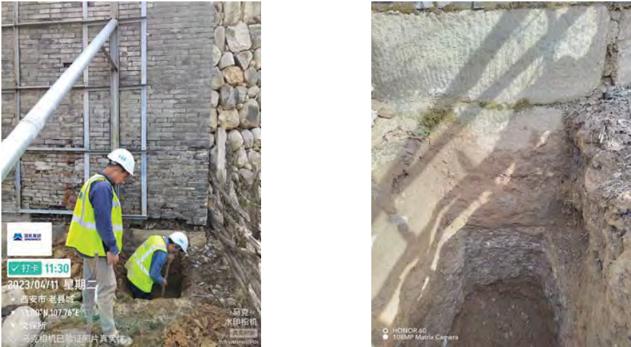
图 3.1-5 探槽揭露地基形式
