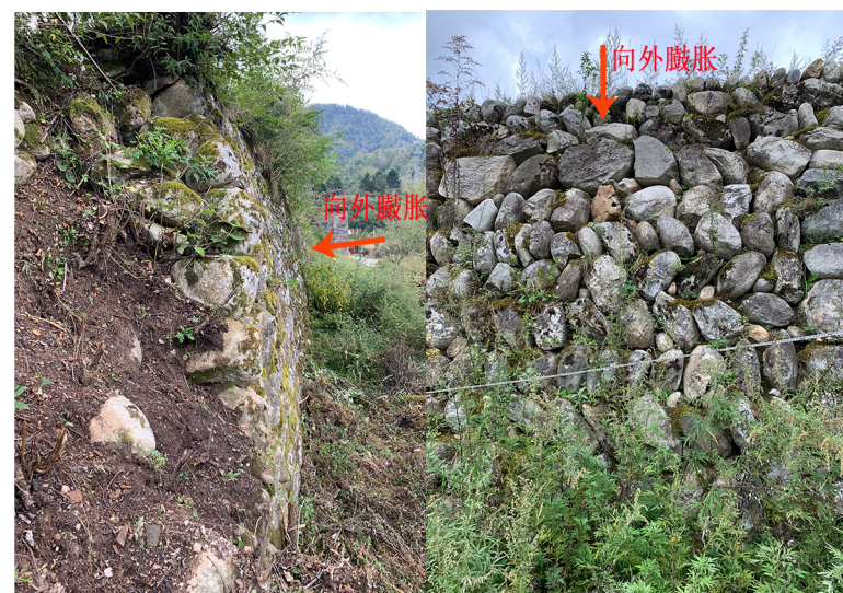
07 C段西面墙体立面现状，墙体向外膨胀 长约24米，高约3.5米（拍摄于2021年9月）
