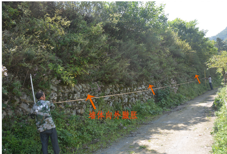
21 E段西面距地约1米，长约30米墙体横向开裂，墙体向外膨胀
