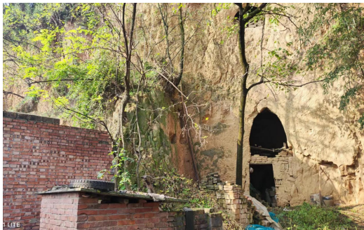
照片 3.2-1 坡面窑洞裂缝（镜向 325°）
