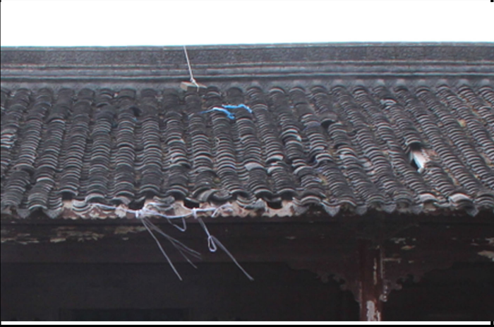
15、前檐檐口局部瓦件塌落
