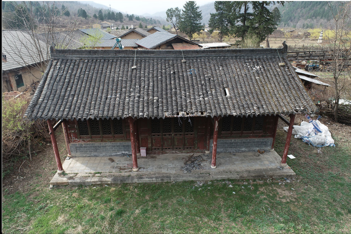
14、前檐屋面瓦件局部塌落
