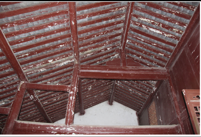
18、木构件表面单色油饰起皮、脱落
