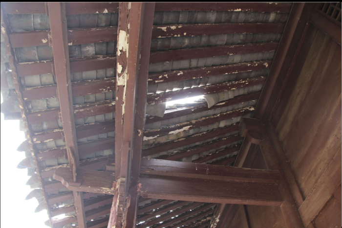
12、前檐廊步瓦件局部塌落
