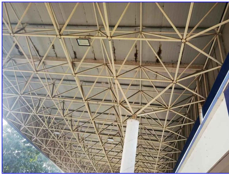
地磅大棚顶盖年久失修、锈蚀严重
