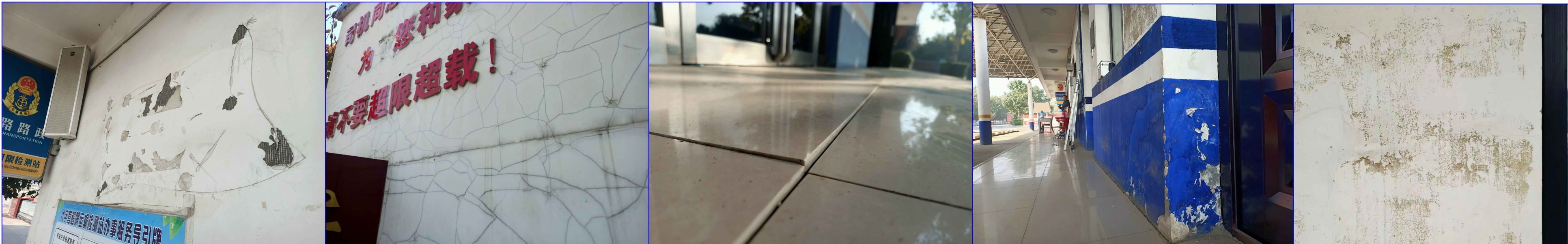
检测大厅墙皮脱落、地板沉降严重
