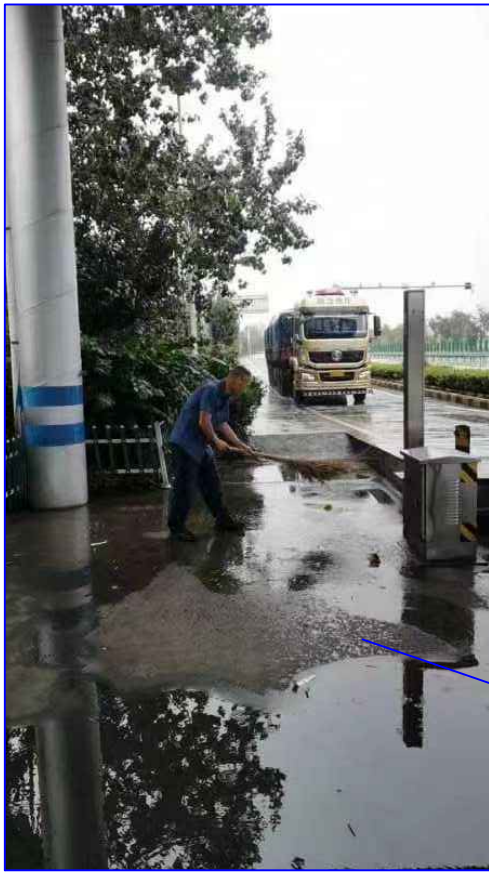
地磅两侧排水不畅积水严重
