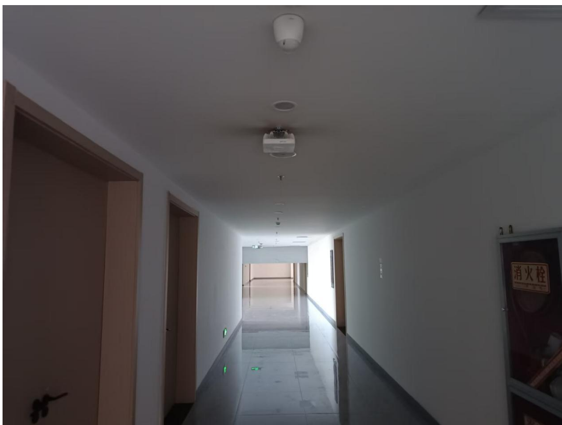
6、五楼联动测试，多数排烟系统未按照所划分的防烟分区正常启动
