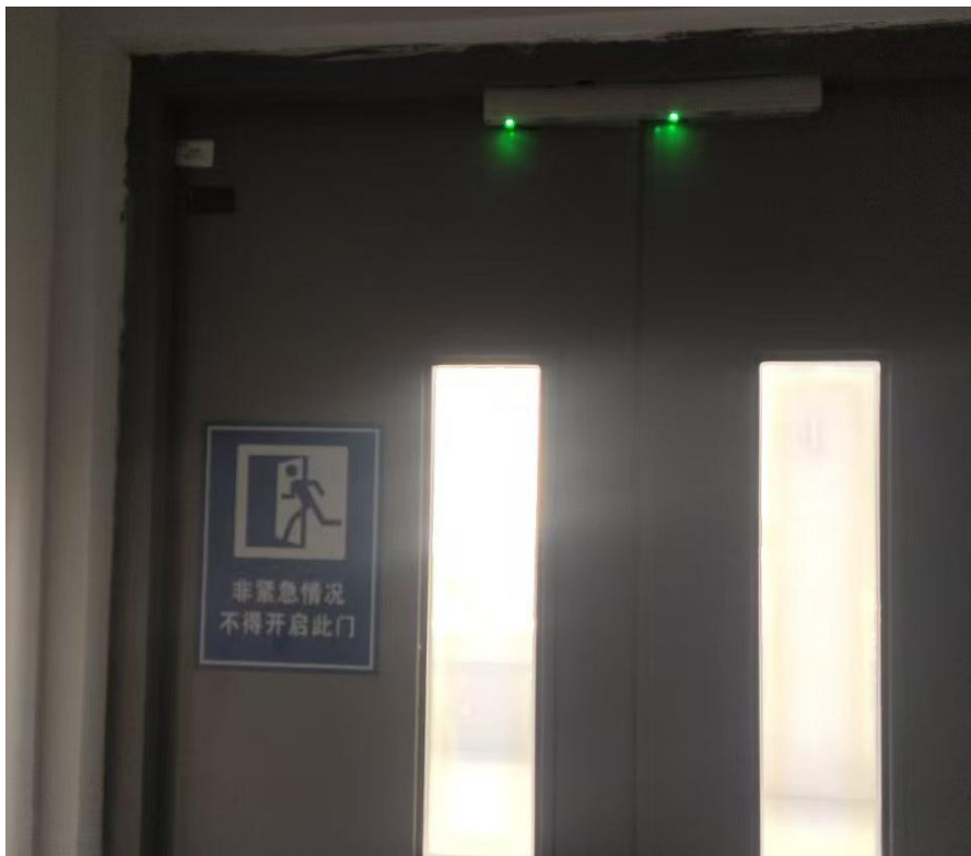
6、科研楼电动挡烟垂壁 7 层到 13 层没有就地手动控制装置
