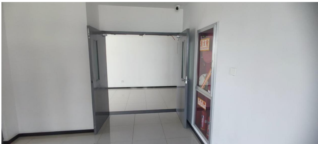
7、楼梯间常开双扇防火门一扇缺少闭门器，整体缺少顺序器，无防火门常闭标识
