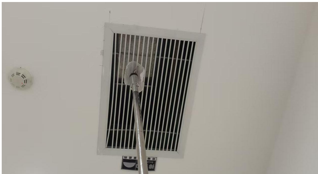
4、科研楼六层联动测试电动挡烟垂壁未动作
