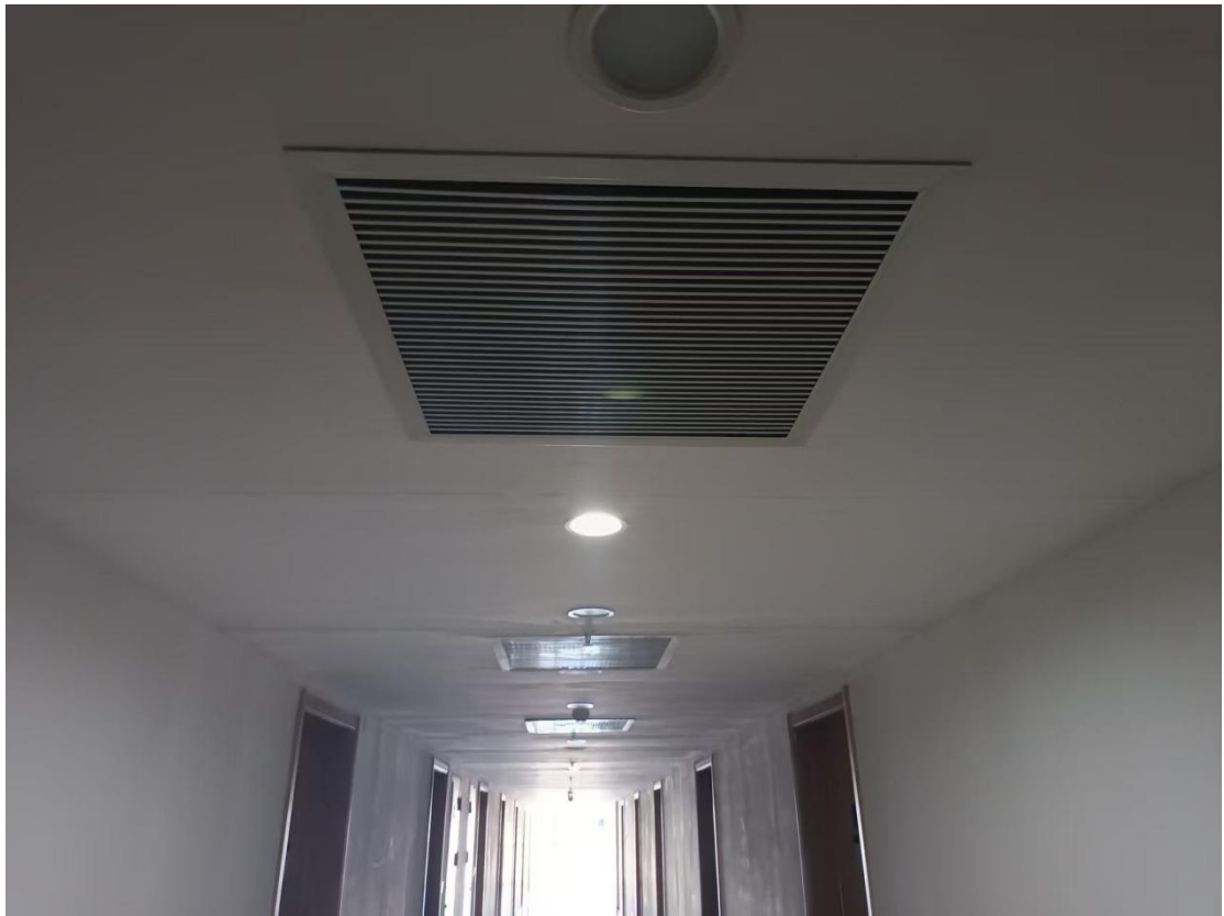
7、联动测试，走道东消防前室一台送风机未启动，风口无风速
