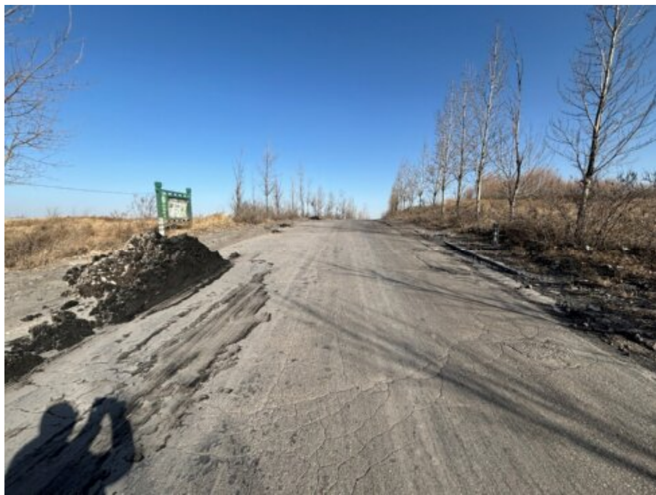
郝石公路采空塌陷维修起点段
