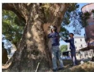
清理腐烂木质部
