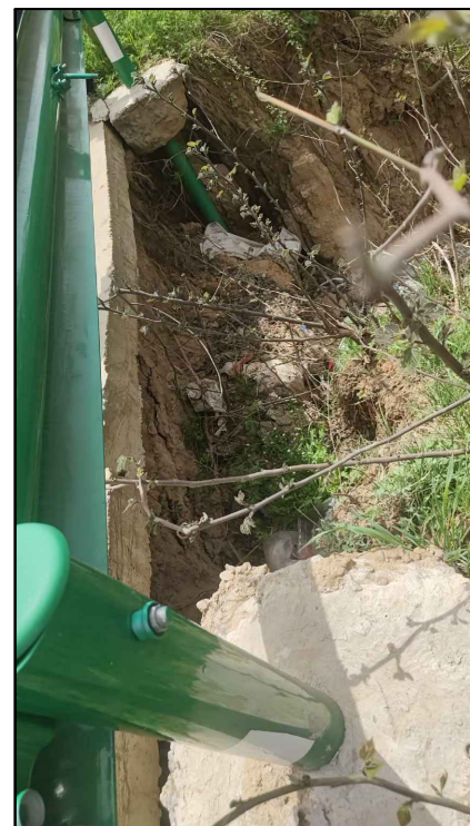
樊河组修缮路段—2
