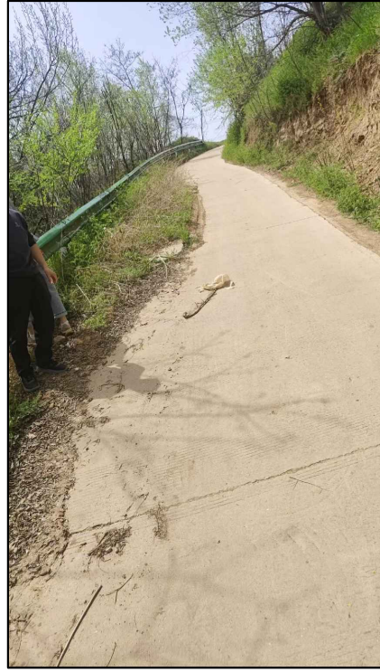
蒋曹组修缮路段一
