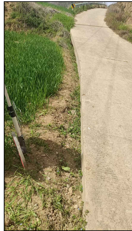
西王坡组修缮路段一
