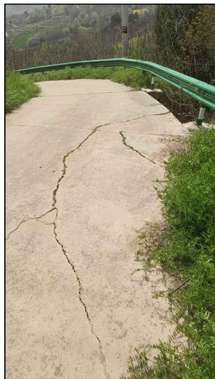
樊河组修缮路段—1
